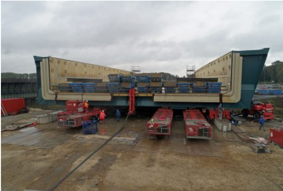
Verschubkonstruktion mit Ballastierung und Verschubschlitten
