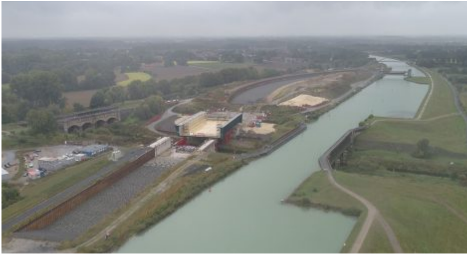
3 Generationen von Kanalbrücken: Im Vordergrund der ausgebaute Dortmund –Ems-Kanal mit der Engstelle der Kanalbrücke Ems von 1935/36. Links daneben die Umfahungsstrecke mit dem neuen Brückentrog. Ganz links die denkmalgeschützte Kanalbrücke von 1899.
