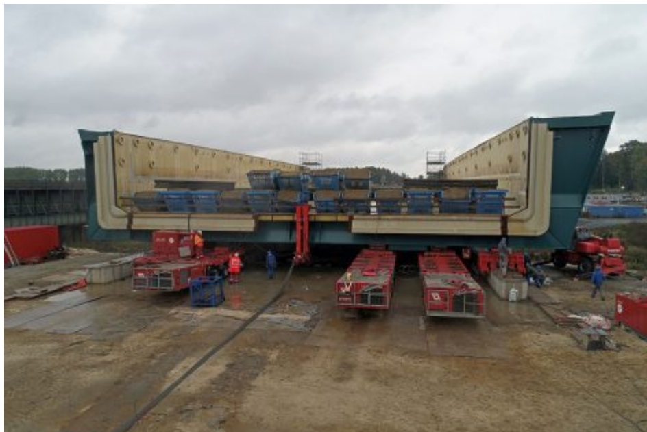
Verschubkonstruktion mit Ballastierung und Verschubschlitten
